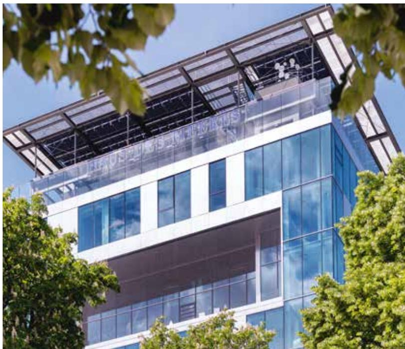
Das neue Solardach am Haus des Meeres besteht aus 202 speziellen bifazialen Glas-Glas-Photovoltaikmodulen und erzeugt so Strom nicht nur von oben, sondern auch von unten.
